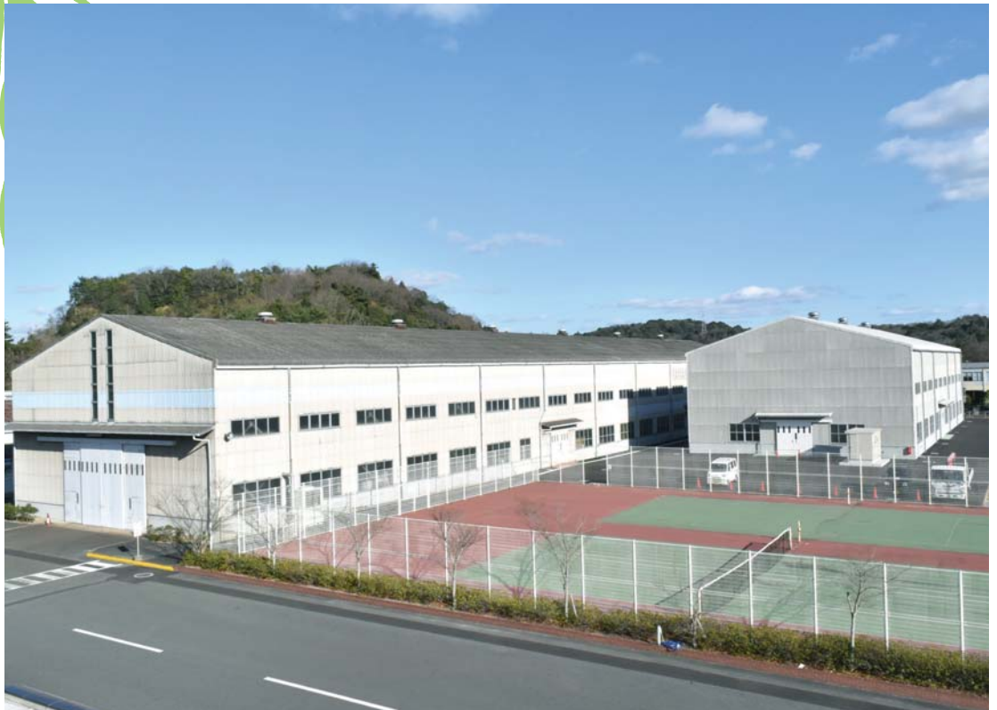
「未来への夢工場、第3工場完成！」
